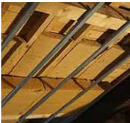
Isolation sous rampants
