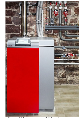
chaudière granulé bois
