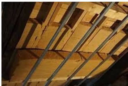
Isolation sous rampants
