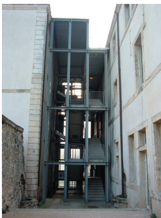
Entre les bâtiments en pierre du corps de garde et de la caserne réaménagés, se glisse la structure métallique abritant les circulations verticales
