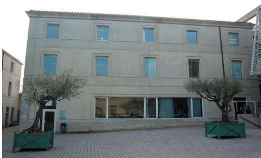
Face à l'ancien logement, le corps de bâtiment neuf en béton, à l'emplacement du logement du commandant, détruit par l'incendie de 1974
