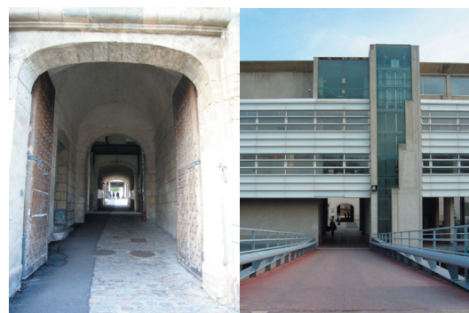
Depuis la montée du Fort, accès à la cour d'honneur et, au delà de la bibliothèque érigée sur pilotis, à l'esplanade nord.
