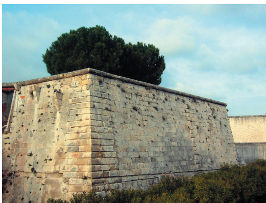
Mise en œuvre «classique» du mur d'escarpe
