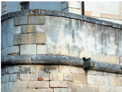
Détail du cordon d'escarpe
