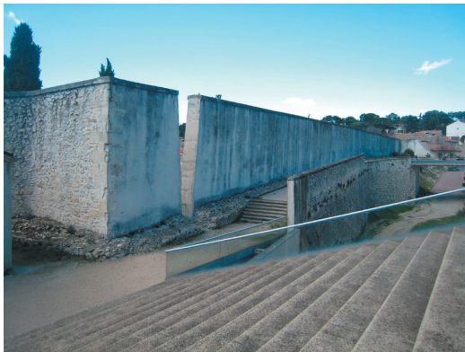
Le chemin couvert, sur la contrescarpe (photo : Cédric Rodot)
