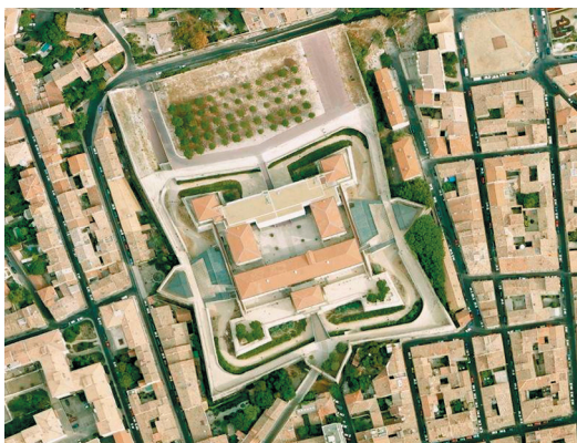
Image Google Earth : au Sud-Ouest, accès piéton par la montée du Fort, au Nord-Ouest, accès voiture par la percée sur la rue Vincent
