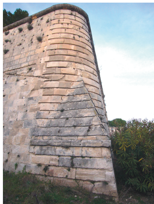
Appareil soigné d'un éperon
