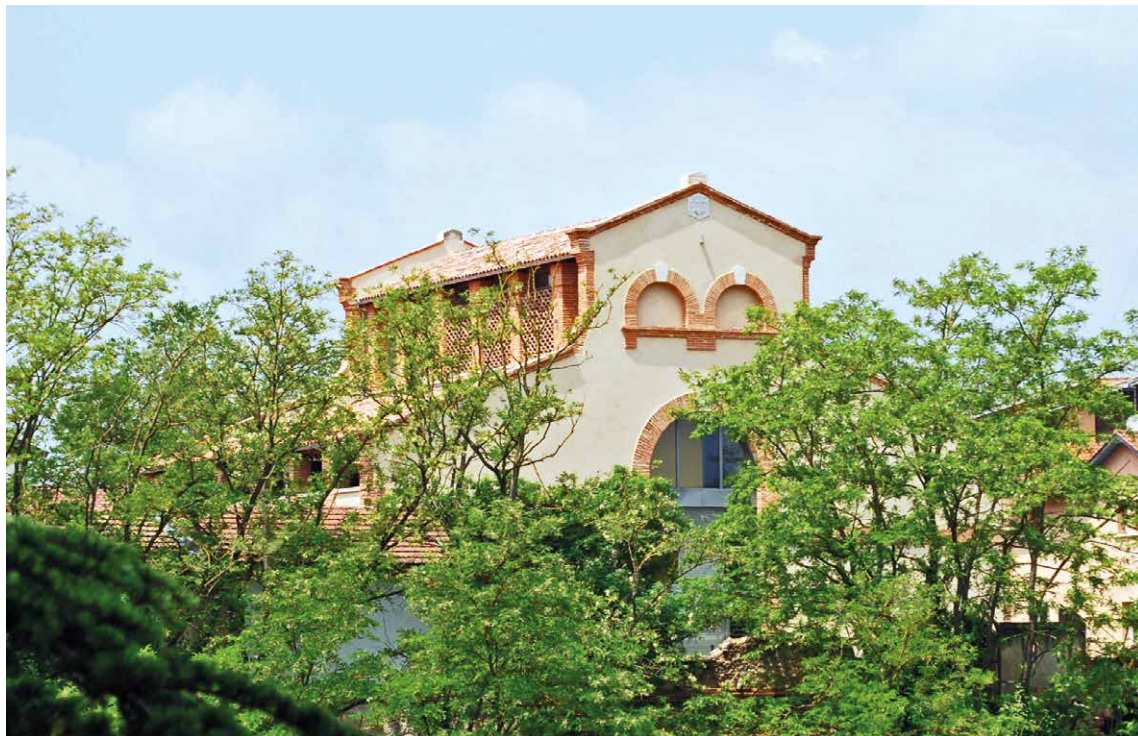
Vue depuis le pont
