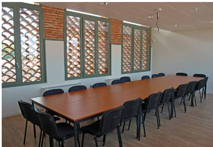
Salle de réunion bénéficiant de claustras en brique de terre-cuite
