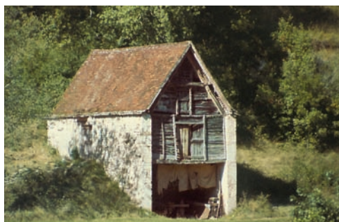
L'utilisation de panneaux persiennés permet d'éclairer l'intérieur tout en conservant le principe d'une façade en bardage bois.
