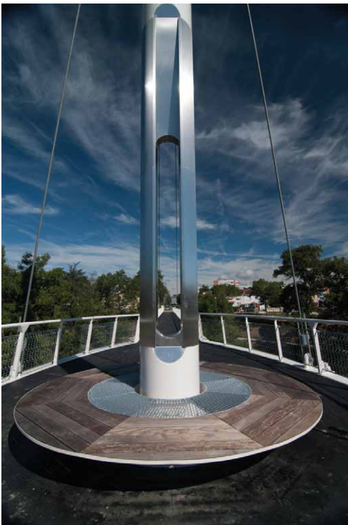
La passerelle et son mât en forme d'aiguille
