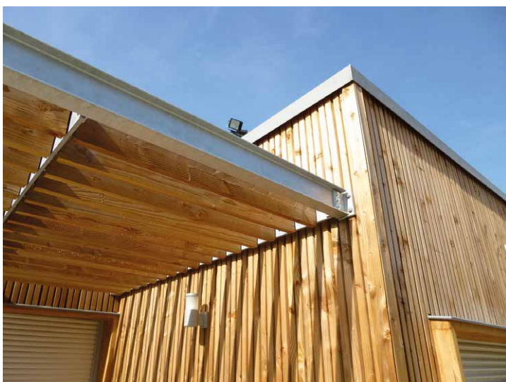
Détails du bardage et de la pergola, façade Sud-Est
