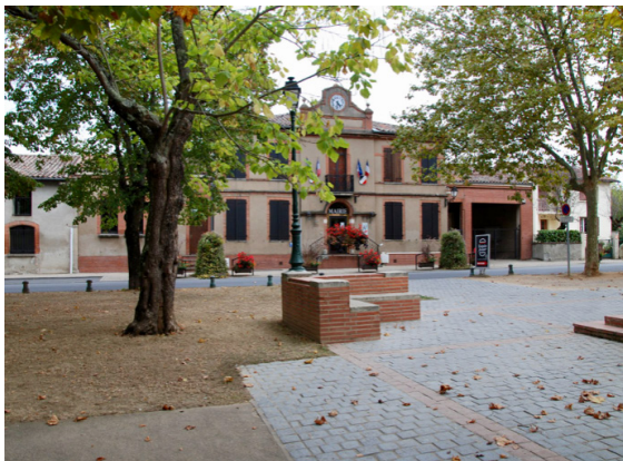
Mairie avant travaux / source : atelier-atp.com
