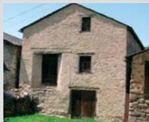
L'enduit à pierre vue doit être mis en œuvre de manière à évoquer l'usure et la patine du temps, plus que la mise à nu systématique de grosses pierres de l'appareillage.
