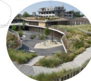
Les toitures végétalisées
