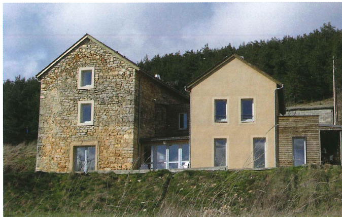
Construction mixte, La Capelle - Architecte : Marie-Claire Bessin
