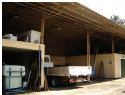
Hangar métallique abritant le matériel agricole.
