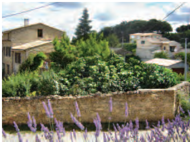
Rénovations traditionnelles et constructions récentes se côtoient.
