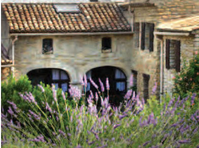
Le Mas Sellier : un hameau aux bâtiments rénovés dans le respect de l'architecture locale.
