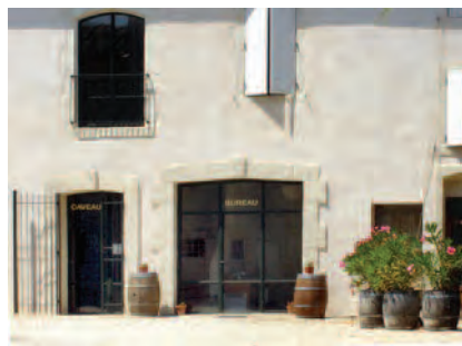
Entrée du caveau et des bureaux.
