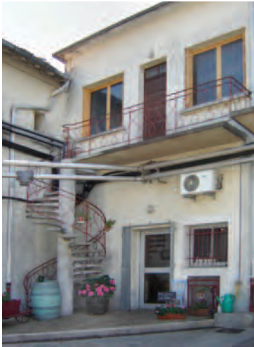
Le caveau au rez-de-chaussée jouxte la cave.
