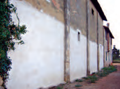
Anciens logements ouvriers en attente de réhabilitation.
