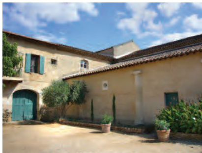
Bonne intégration au bâti ancien d'une partie récemment rénovée.
