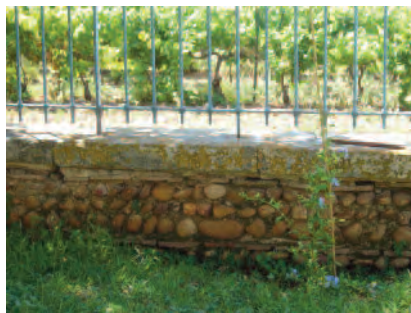
Parement mixte pierres-galets pour ce mur de clôture.
