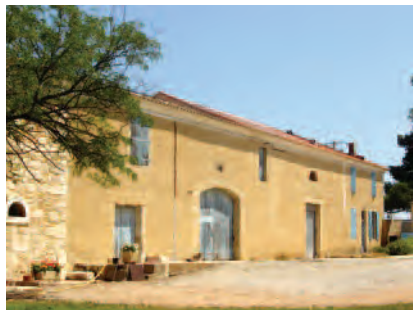
Rythme des façades récemment restaurées de la cave particulière.
