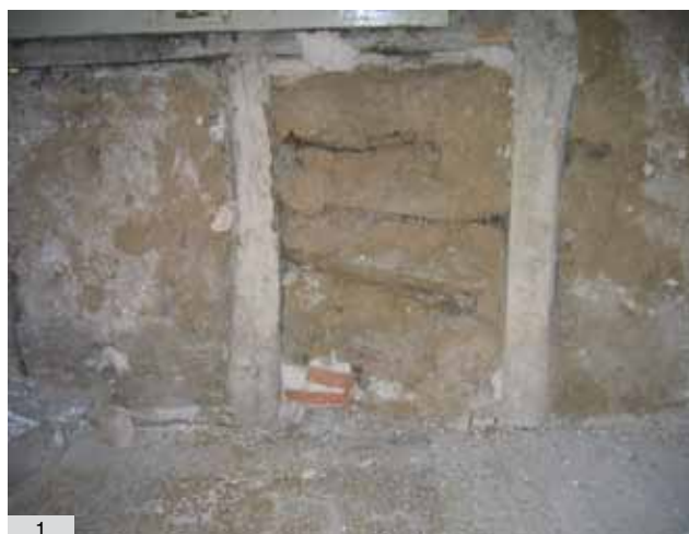
1. Remplissage en torchis à Durfort, Tarn
