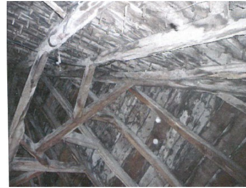
Charpente conservée et redressée
