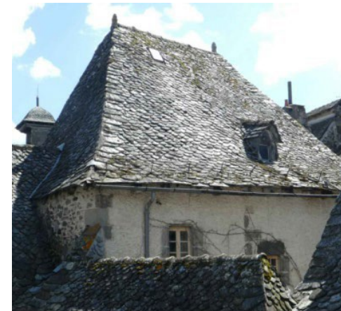
Toit en Lauze du bâtiment
