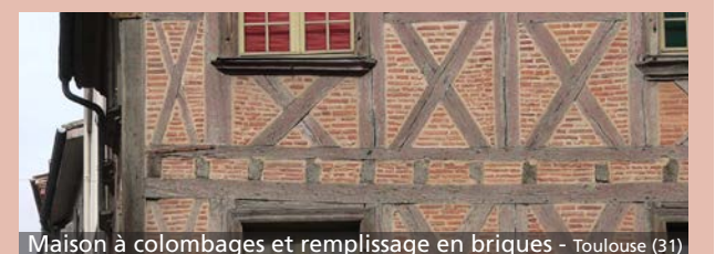
Maison à colombages et remplissage en briques - Toulouse (31)
