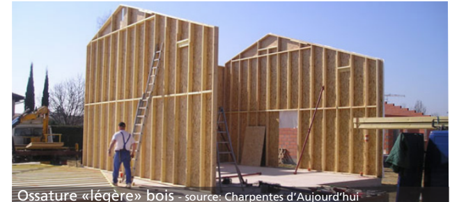
Ossature «légère» bois - source: Charpentes d'Aujourd'hui
