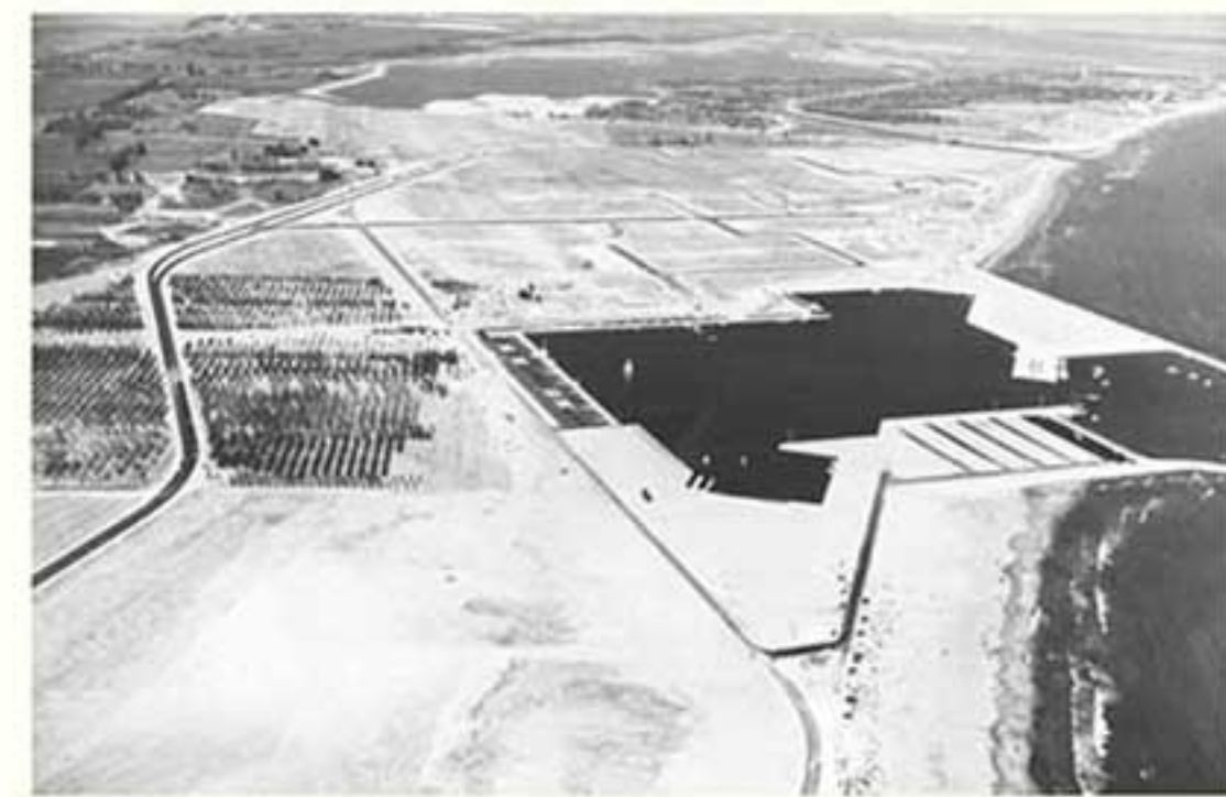
La mise en place des infrastructures ©Fonds Candilis, SIAF/Cité de l'architecture et du patrimoine/Archives d'architecture contemporaine
