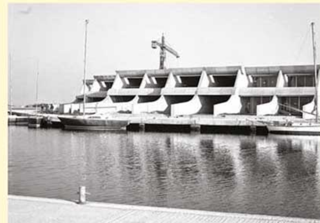
Marina en cours de construction
