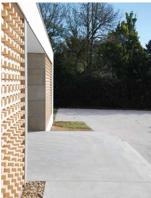
Détails des façades, vues sur les claustras de brique
