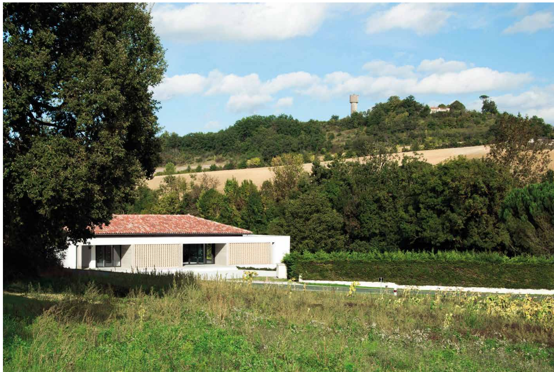
Vue générale, façade Sud desservant les nouvelles entités
