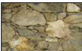
Maçonnerie dépossédée de son enduit. Le risque : destabilisation du mur à long terme.
