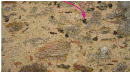
intégration dans la maçonnerie- de scories de bas fourneaux
