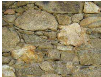
Maçonnerie de pierres (granit, schiste,...) et de mortier de terre et de chaux
