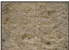
Enduit couvrant d'origine composé de chaux et de sable granitique.
