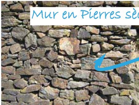
intégration dans la maçonnerie- de scories de bas fourneaux
