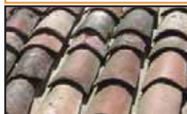
Tuiles canal anciennes patinée par le temps : mousse, décoloration, ...
