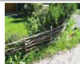
Plessage en noisetier réalisé par le propriétaire.
