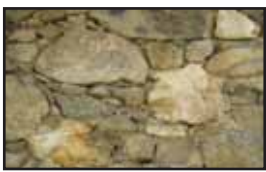
Maçonnerie dépossédée de son enduit. Le risque : mur destabilisé à long terme.
