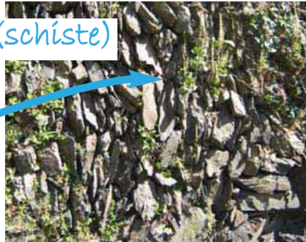
Maçonnerie de pierres (granit, schiste,...) et de mortier de terre et de chaux
