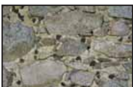
Maçonnerie réalisée avec des pierres et des scories de bas fourneaux, dépossédée de son enduit. Les scories permettent de renforcer la maçonnerie mais n'ont pas de but décoratif.
