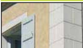
Décors peints réalisés avec un badigeon de chaux teinté avec des pigments naturels, donnant à la chaîne d'angle et à l'encadrement des ouvertures une allure de pierre de taille.
