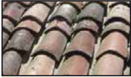
Tuiles canal ancienne spatinées par le temps : mousse, décoloration, ...
