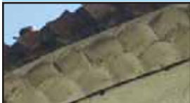
Génoise à double rang, badigeonnée de chaux aérienne pour une bonne résistance aux intempéries.
