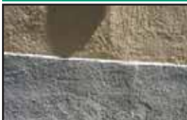
Décors réalisés avec un badigeon de chaux et pigments naturels.
