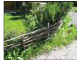
Plessage en noisetier réalisé par le propriétaire.
