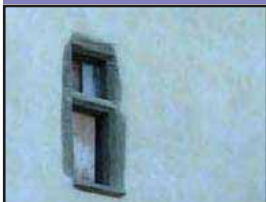
Enduit à la chaux naturelle, taloché fin.
