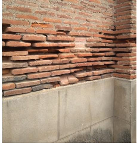
Des traces d'humidité en pied de façade, des joints dégradés entre les briques par les remontées capillaires : le soubassement étanche n'est pas adapté à cette façade ancienne en brique.
