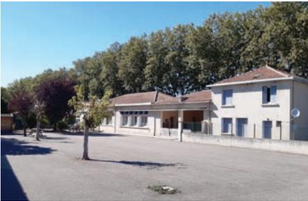
Au dessus des classes, une isolation de la toiture est présente en faible épaisseur. Les menuiseries existantes, dont une grande partie est orientée plein Sud, sont en bois avec un double vitrage ancien et sans volets pour l'ensemble. La ventilation des classes se fait par l'ouverture des portes et des fenêtres. Le chauffage est assuré par des radiateurs fonctionnant au gaz propane.
