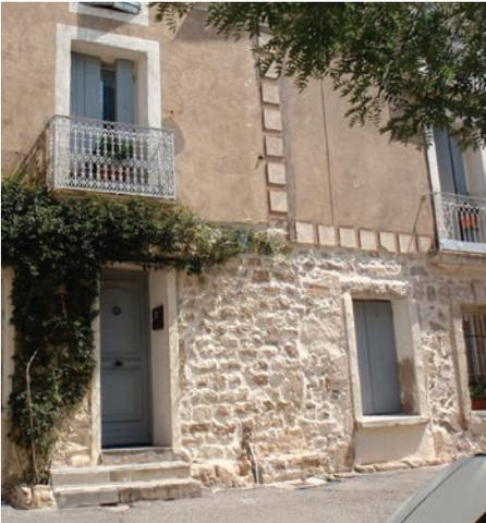
Le rez-de-chaussée de la façade a été «décroûté», la façade est dénaturée et n'est plus protégée.
