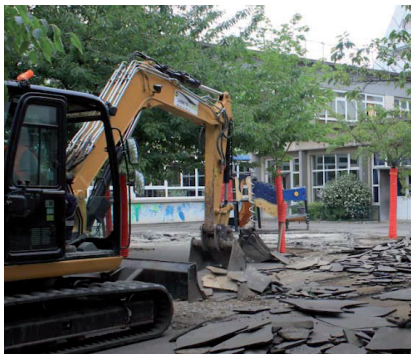
Suppression de l'asphalte dans une cour parisienne © CAUE de Paris
