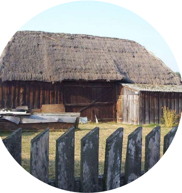
Exemple : grange aménagée en habitation
