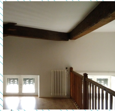
Photo AVANT / une des mezzanines
