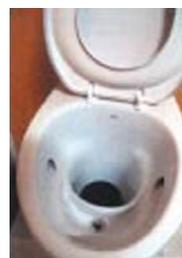
*Il existe des modèles de toilettes sèches plus élaborés avec séparation des urines et des matières fécales. Ces systèmes, plus coûteux (2 000 euros) impliquent des opérations de maintenance et de vidange moins fréquentes.*
