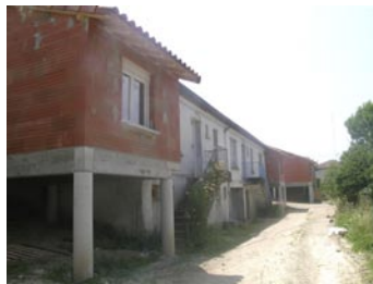
Façade Nord en travaux
