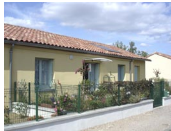
Façade Sud sur rue - après travaux
