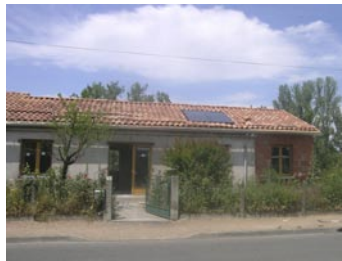
Façade Sud sur rue - en travaux
