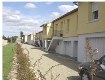
Façade Nord - après travaux
