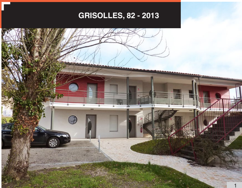
1. Vue générale de l'extension de l'hôtel
