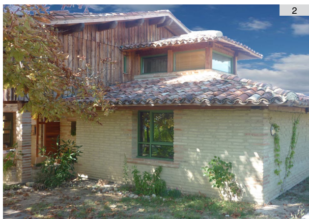
1. Chantier réhabilitation, 82 2. Maison D., 82, architecte : P. DELPRAT
