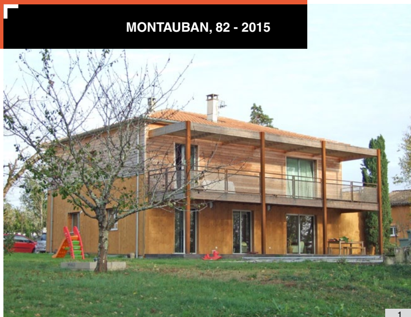
1. Façade Sud-Ouest après travaux de réhabilitation : baies élargies, brise-soleil, bardage bois
