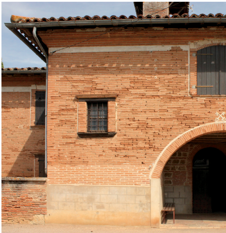
Eglise de Bracou, Couffouleux - © CAUE81
