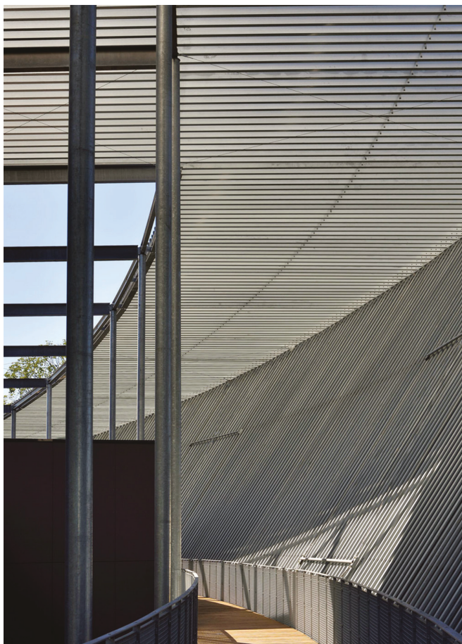
Lacombe & De Florinier architectes - Centre nautique, Carmaux
