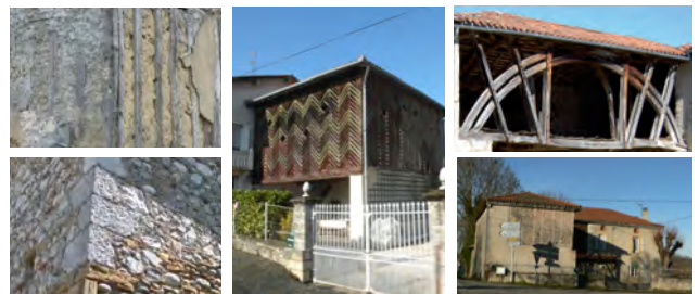
3 Matériaux traditionnels de construction et lattis de grange
