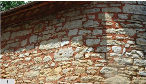
1. Murs en moellons hourdés au mortier coloré.
