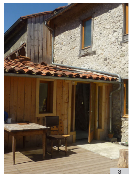
3. Vue arrière du bâtiment principal avec l'ajout du volume annexe bardé de bois ( photo Jean-luc FAUVEL)
