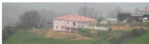
6 Implantation à grand renfort de terrassement
