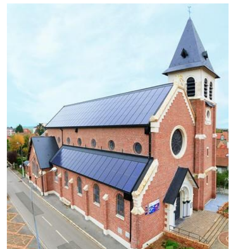
Eglise St-Vaast, Loos-en-Gohelle Panneaux solaires sur le toit de l'église - 2014
