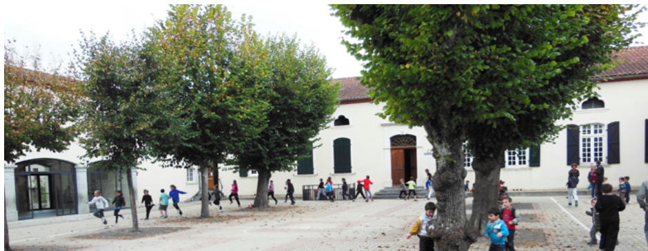
Vue générale sur le bâtiment Mairie-École, formant un U autour de la cour de récréation. La mise en accessibilité de ces deux structures doit respecter les qualités architecturales du bâtiment.
