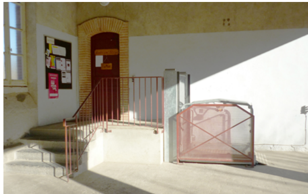
La mise en place d'un monte personne permet à la bibliothèque municipale de répondre aux règles d'accessibilité fixées par la loi du 11 février 2005. Commune de Castelnau-Durban
