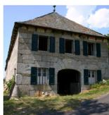
Granite massif appareillé à joints vifs de la Viadène
