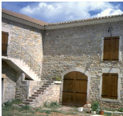
*Bouillargues : maçonnerie composite utilisant la pierre, le galet et la brique*
