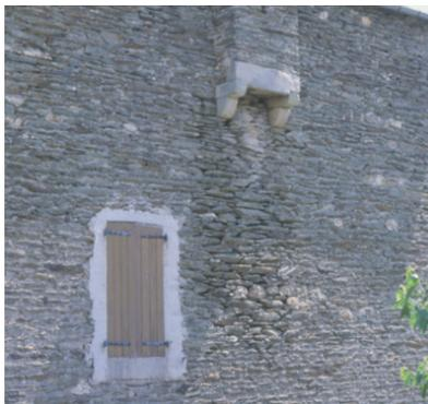
Pontails : parement de schiste, encadrement de calcaire
