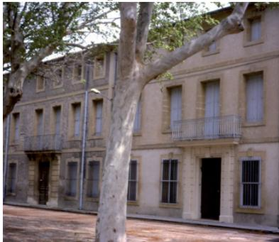
Marsillargues : la pierre taillée est visible dans les encadrements, les chaînages verticaux, les chaînages horizontaux de traitement des planchers
