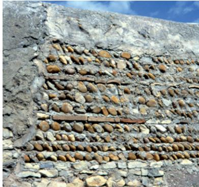
*Bouillargues : paroi réalisée avec un parement de galets et parefeuilles hourdés au mortier de terre*
