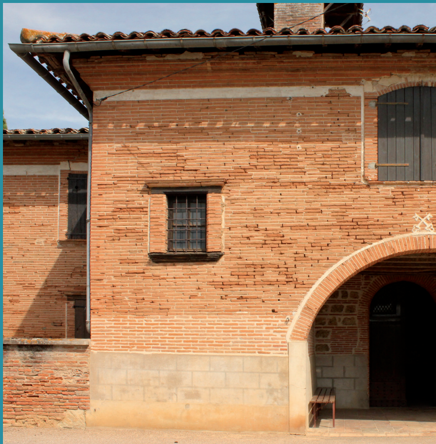
Eglise de Bracou, Couffouleux - © CAUE81
