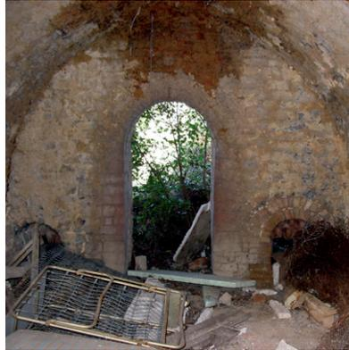
Vue intérieure du four est (de part et d'autre de l'entrée, on distingue, au ras du sol, les deux ouvertures des foyers)
