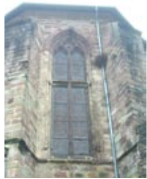
baie haute à remplage
