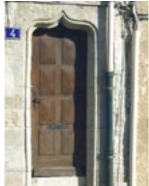
arc en accolade
