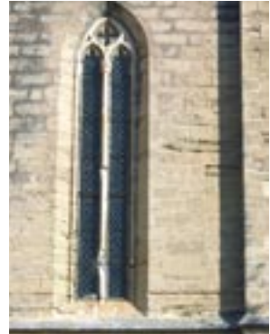
baie haute à remplage
