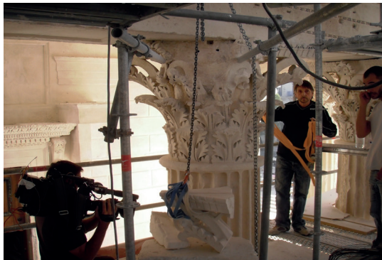
Chantier de restauration de la Maison Carrée, Nîmes (2010)
