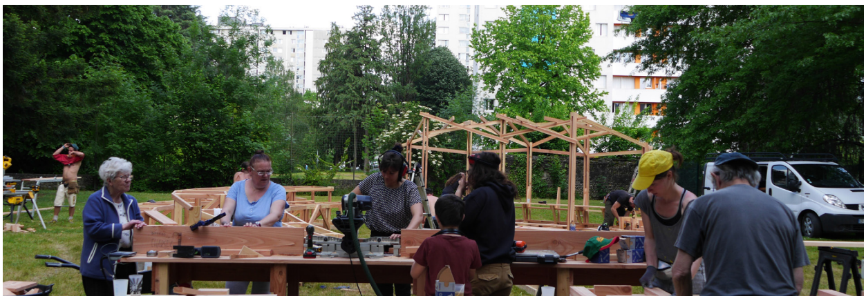
Pau (64). Chantier participatif, aménagement du jardin invisible. ©BruitduFrigo
