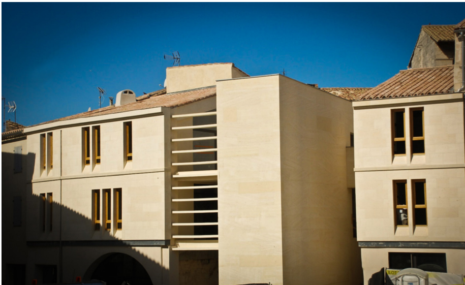
Prix architecture du CAUE 2019. Réhabilitation îlot 2D face à l'abbatiale de Saint-Gilles. ©Atelier DONJERKOVIC
