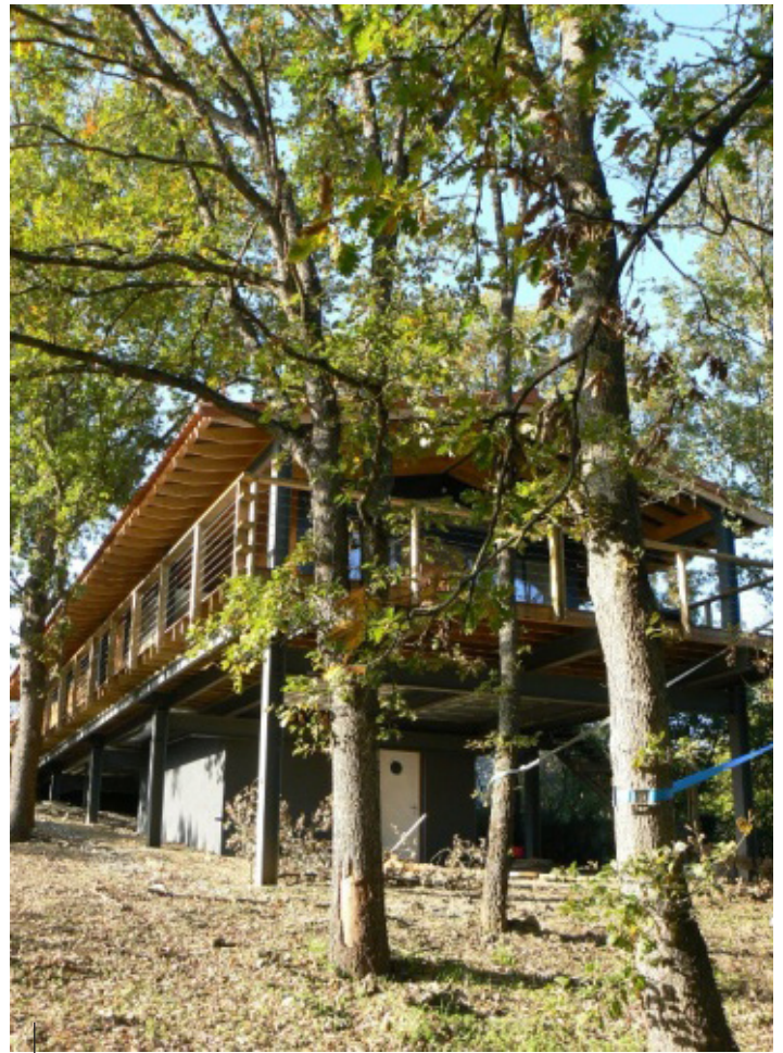
Vue de la structure mixte métal / bois
