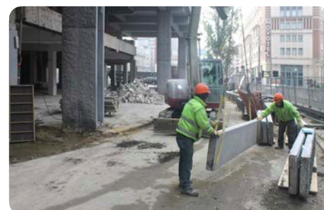
Démontage d'éléments en pierre
