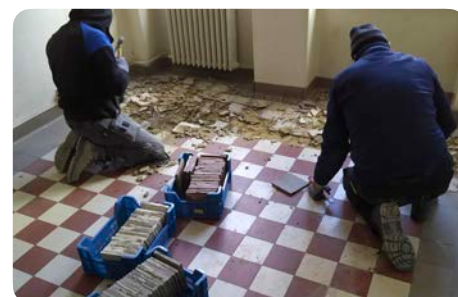
Démontage de carreaux en céramique
