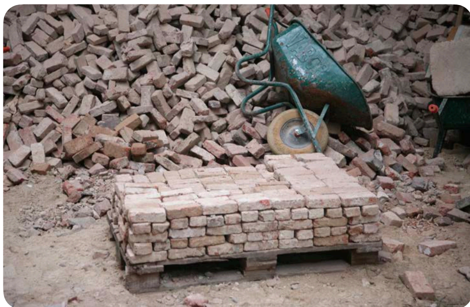
Nettoyage et tri de briques récupérées
