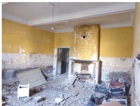
Grande salle du rez-de-chaussée
