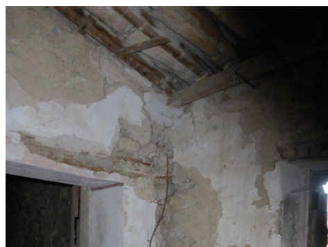
Fissures de décollement de la façade principale visible au 2nd niveau
