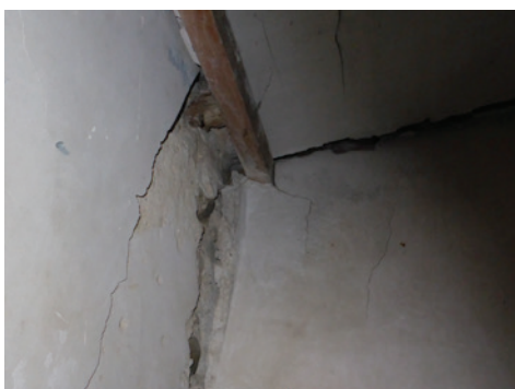
Fissures de décollement de la façade principale visible au 2nd niveau
