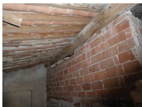
Toiture du 2nd niveau
