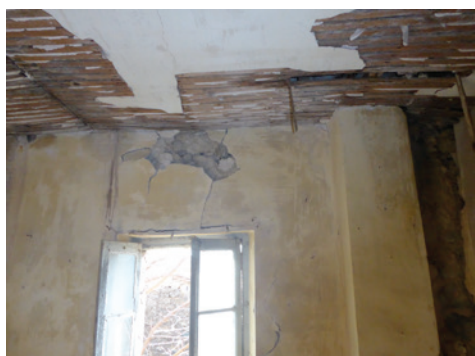
Façade sur cour et faux-plafond au 2nd niveau
