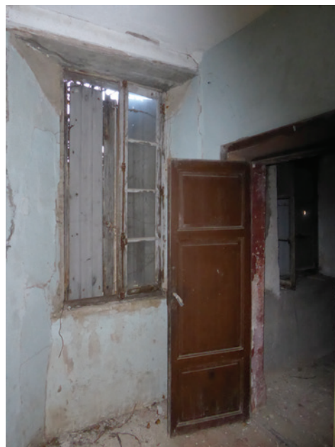
Menuiserie sur palier de l'escalier
