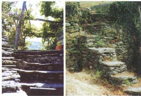
Les anciens réalisaient ces ouvrages avec une grande **simplicité de moyens**, en utilisant les matériaux trouvés sur place. Le dépierrage du terrain fournissait le soutènement ou la clôture, bâti en pierres sèches. Les rejetons de châtaignier fournissaient, une fois écorcés, «le bouscas», pour faire les treilles. Plantes grimpantes et fleurs faisaient le reste.
