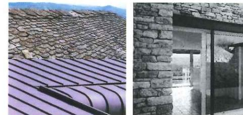
Les techniques et matériaux traditionnels sont adaptés à la réalisation de maisons évolutives au grés des besoins de leurs occupants. Une maçonnerie en moellons calcaires liés à la chaux ou une charpente chevillée, sont des ouvrages facilement démontables, transformables et réutilisables.
