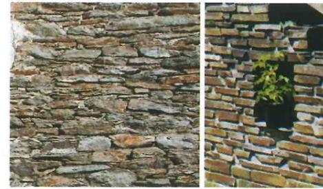
L'expression d'une nature construite, des moellons bruts d'extraction, bloqués entre eux avec un minimum de joint, donnent au mur sa présence vivante. Monté à joints réguliers avec des pierres trop calibrées, le mur se vide de sa substance.
