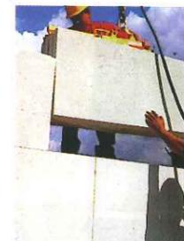
Les éléments industrialisés de grande dimension accélèrent la pose mais demandent une plus grande préparation du support, des assemblages précis et ne supportent pas les déformations ni les formes fluides.
