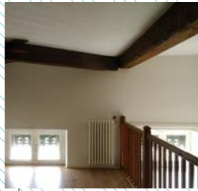
Photo AVANT / une des mezzanines
