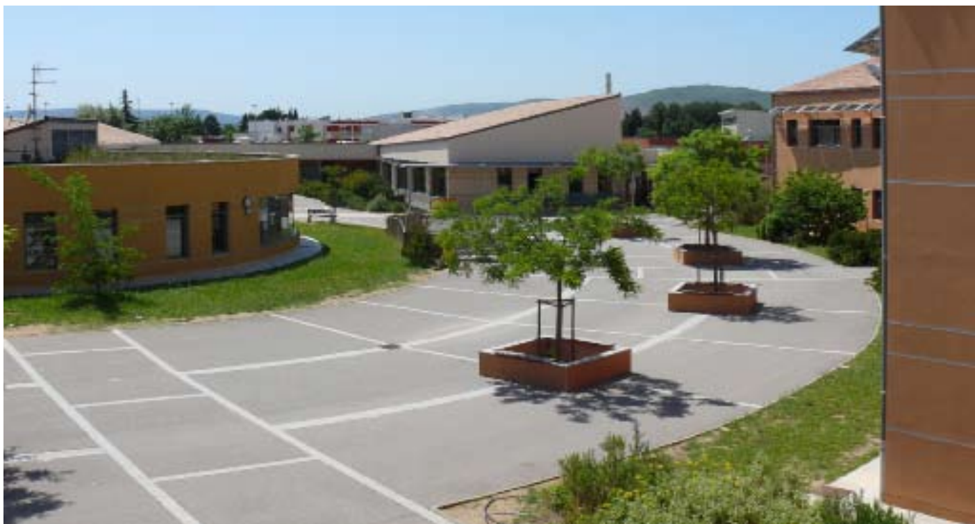
Les ouvertures du CDI, largement dimensionnées sont orientées au nord. La toiture végétalisée joue de son effet isolant en protégeant le bâtiment des écarts thermiques.
