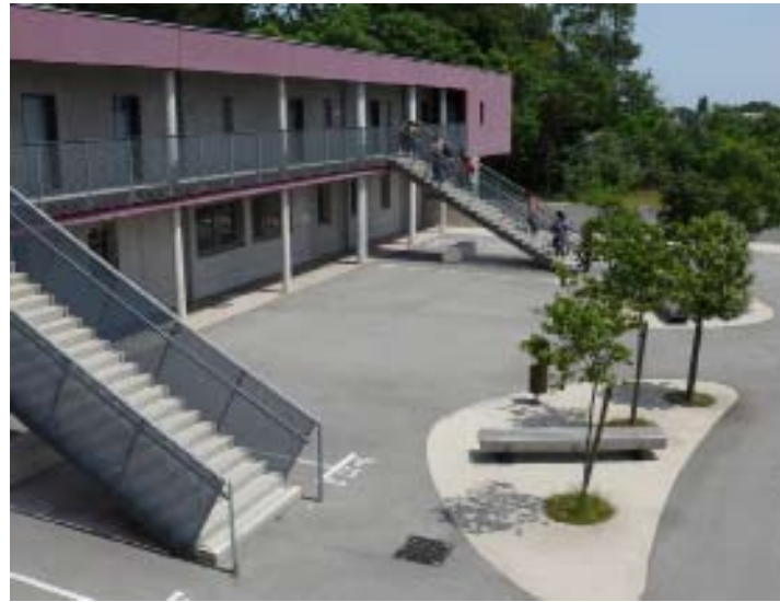
Deux passerelles ludiques perpendiculaires au bâtiment donnent accès, directement depuis la cour, aux salles d'enseignements artistiques et scientifiques situées à l'étage.
