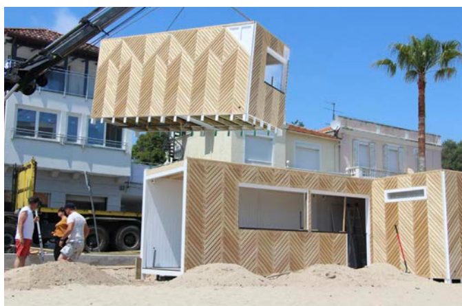
Exemple d'une petite construction en conteneur, revêtue préfabriquée et posée selon des modules agencés.
